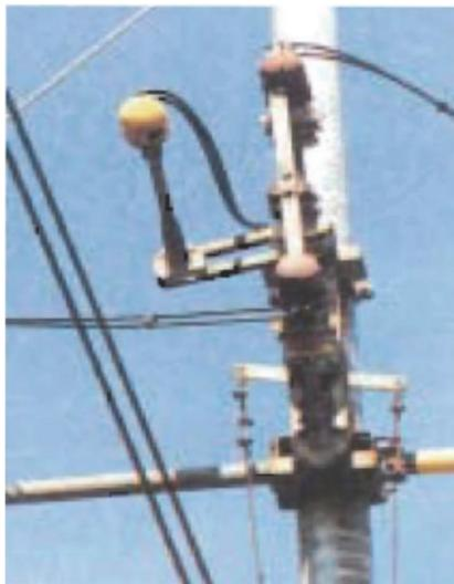
**Fig. 8 : Commutatore in posizione di chiuso**
