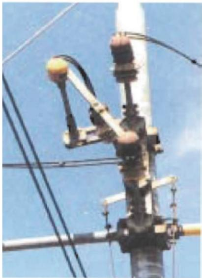
**Fig. 6: Commutatore in posizione di aperto con collegamento a terra della linea**
